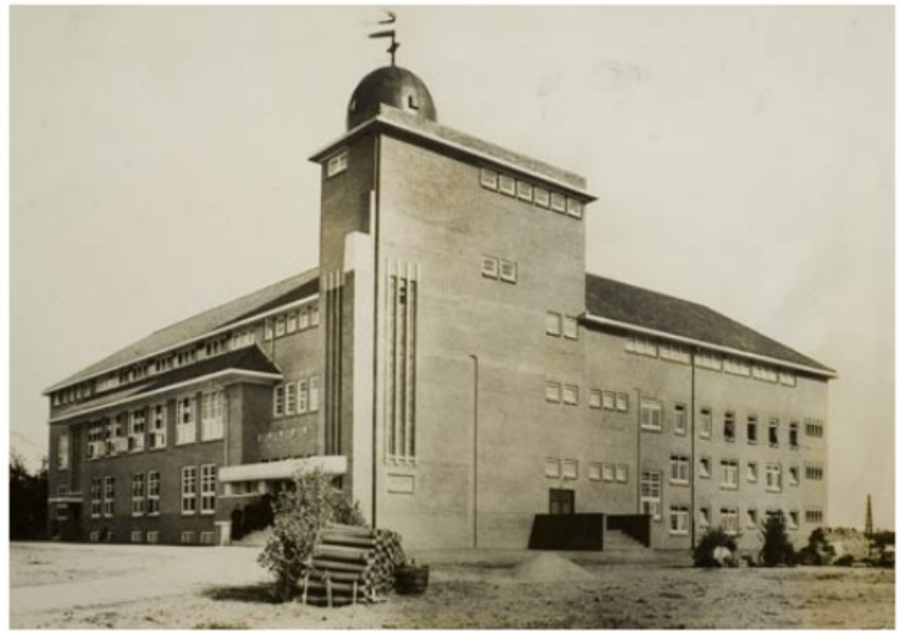
Missiehuis Christus Koning vlak na de inwijding, juni 1930. Fase 1 van de bouw is afgerond. De bouwmaterialen voor fase 2 (de kapel en recreatiezaal) liggen al klaar. (Fotopersbureau Het Zuiden, collectie RHCe)
